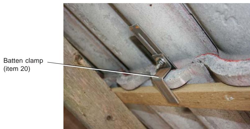
Fig. 13 - Batten clamp
